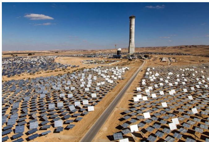
Figura 7 - Concentrador solar de Torre Central da Usina Ashalim em Israrel
