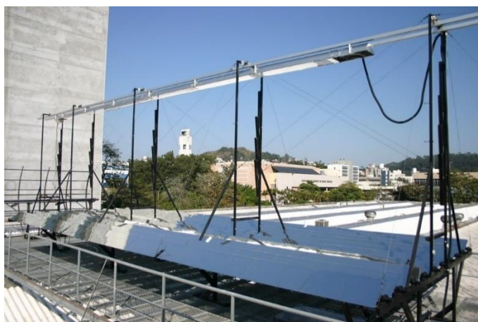
Figura 5 - Concentrador solar tipo Fresnel Linear localizado em Florianópolis (SC)
