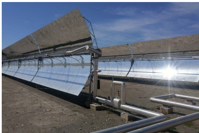
Figura 4 - Concentrador cilíndrico parabólico localizado em Aparecida de Goiânia (GO)
