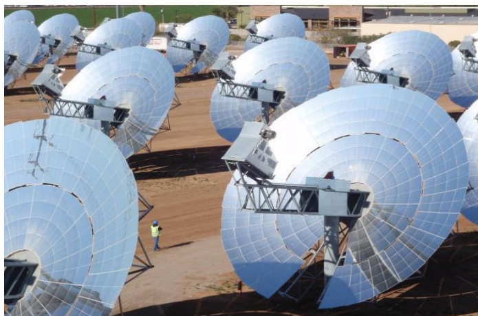
Figura 6 - Concentrador solar com foco pontual em usina solar no Arizona, USA
